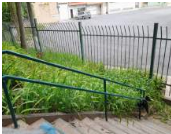
Figura 50 Despraguejamento de canteiro
