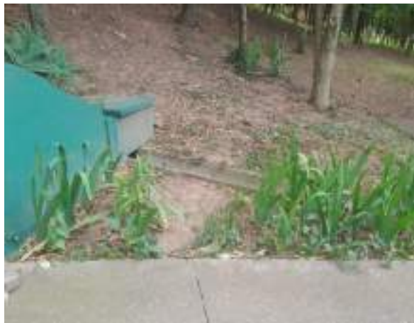
Figura 41 Reconstrução de canteiro, antes
