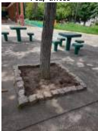
Figura 25 Reconstrução do canteiro do P02, antes
