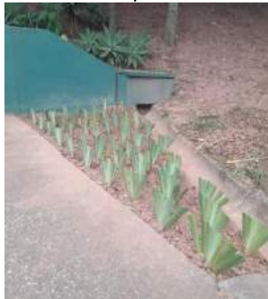
Figura 42 Reconstrução de canteiro, depois
