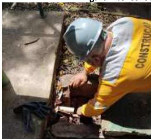
Figura 163 Conserto de cano do bebedouro
