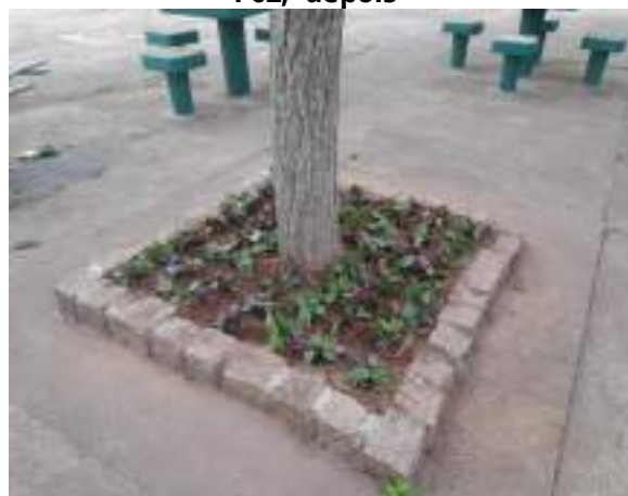
Figura 26 Reconstrução do canteiro do P02, depois
